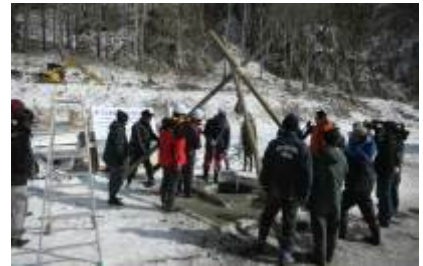
井戸復元作業（平成25年2月）
